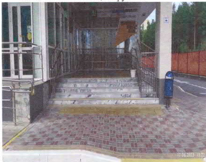
ФОТО № 10 Лестница наружная
