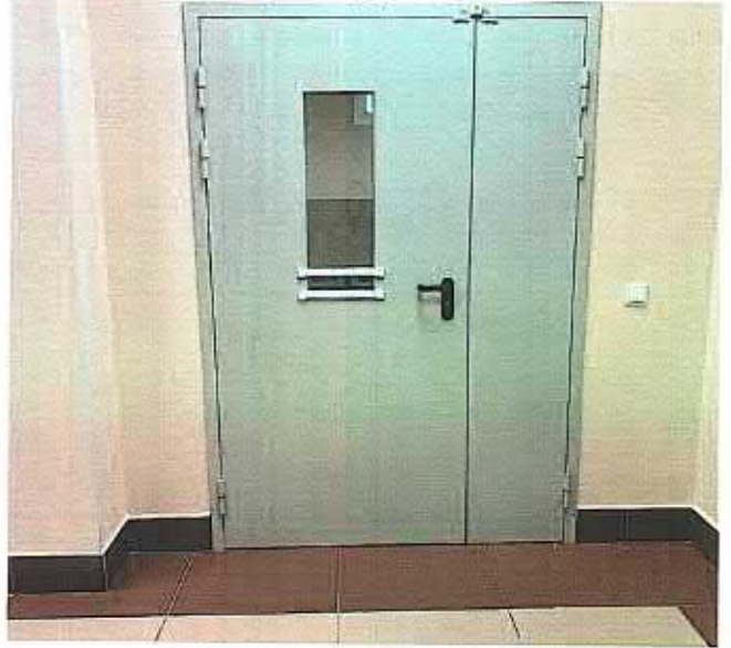
ФОТО № 32 Двери внутри здания
