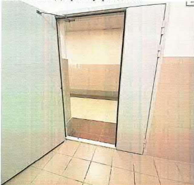
ФОТО № 35 Двери внутри здания
